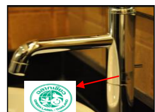
ภาพที่ 2-10 อุปกรณ์แบบประหยัดน้ำและป้ายรณรงค์การประหยัดน้ำ
