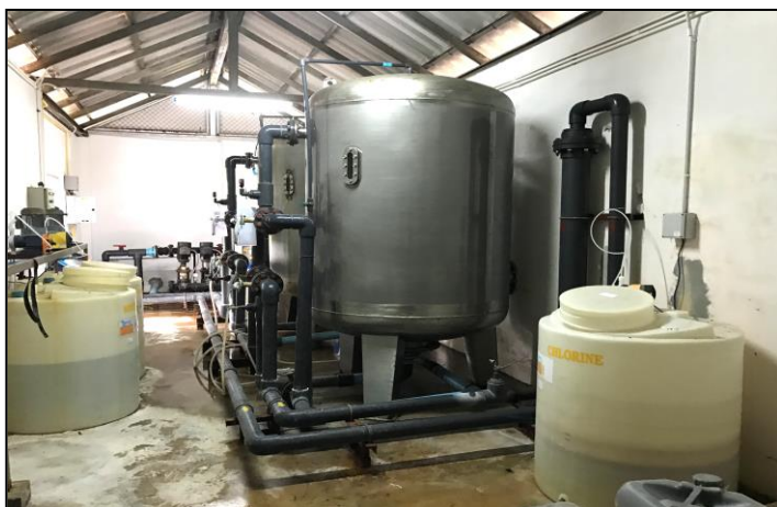
ภาพที่ 1-4 Plant น้ำประปาโครงการฯ และภาพถังเก็บน้ำบาดาล
